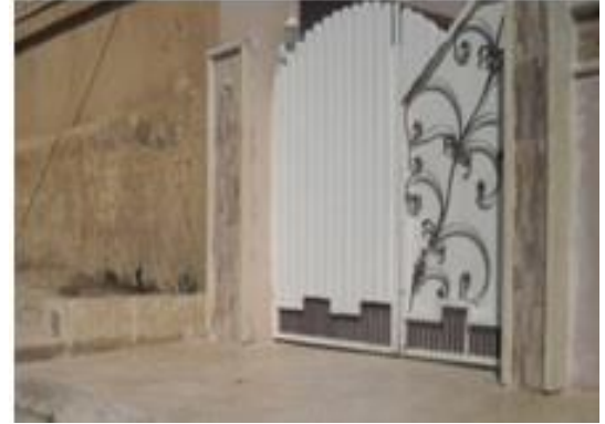
شكل رقم (14) : نموذج للحواجز البنائية المعترضة لمسار المشاة على الرصيف (المصدر : الباحث) .
